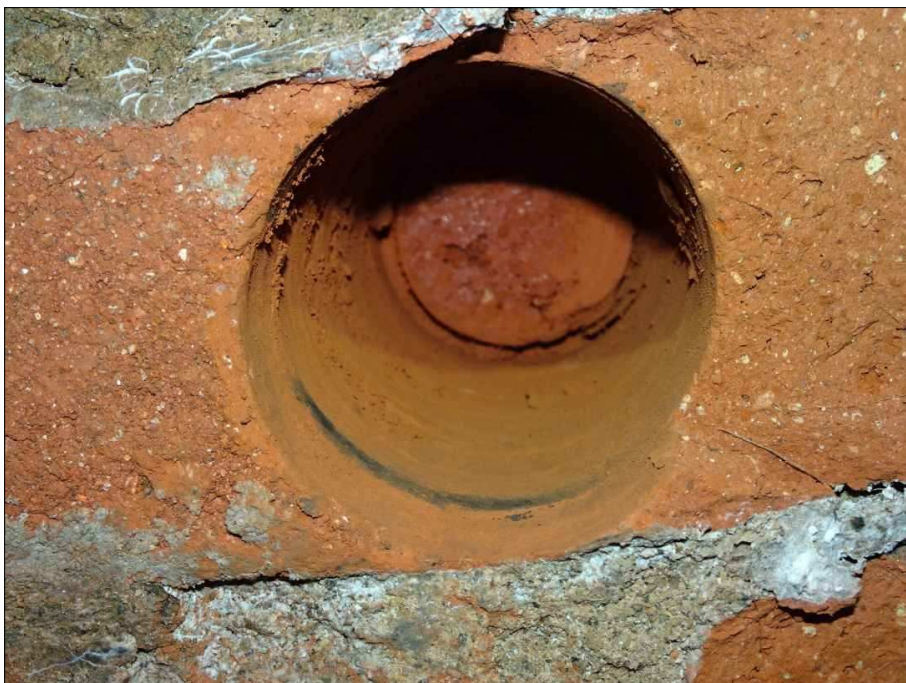
Foto č.6 - místo po provedeném vývrtu
