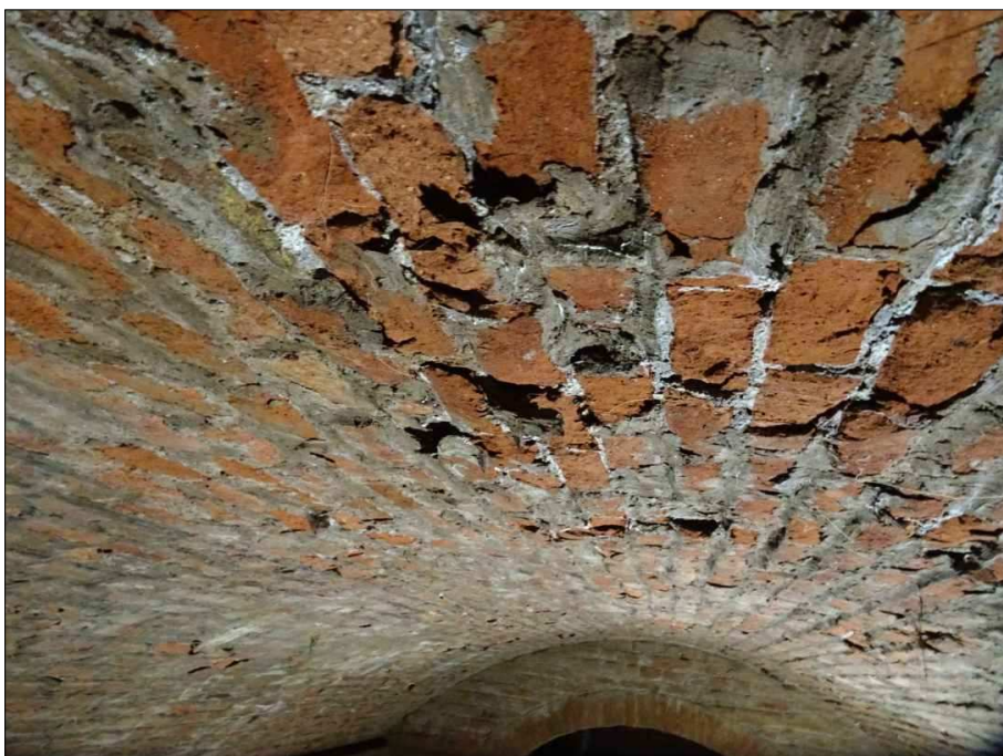
Foto č.2 - detail poškozených cihel
