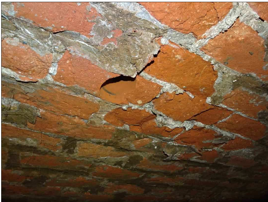
Foto č.5 - pohled na poškozené cihly a místo po provedeném vývrtu
