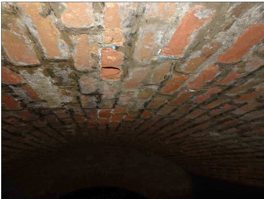
Foto č.3 - pohled na poškozené cihly a místo po provedeném vývrtu
